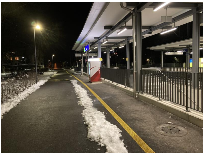
Getränkeautomat im Sichtwinkel beim Bahnhof Steinhof
